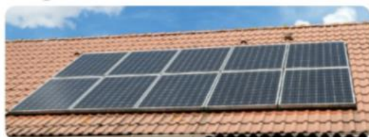
a) Hệ thống pin quang điện
