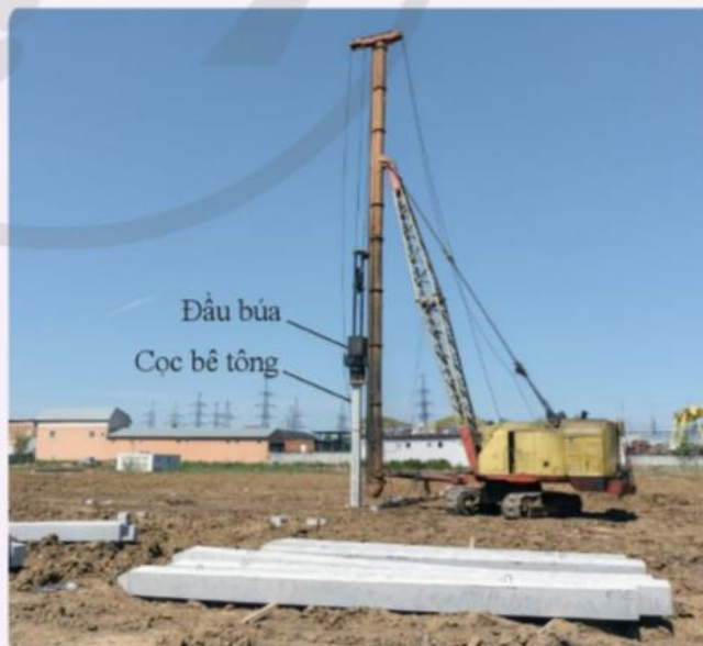
Hình 2.5. Búa máy đóng cọc
