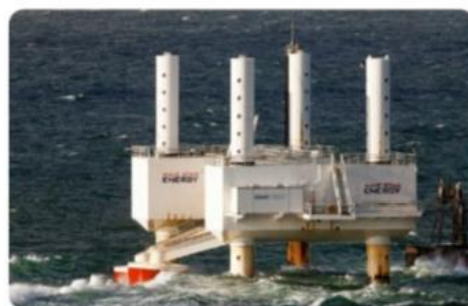
Hình 14.5. Hệ thống chuyển đổi năng lượng từ sóng biển thành năng lượng điện được lắp đặt tại Đan Mạch
